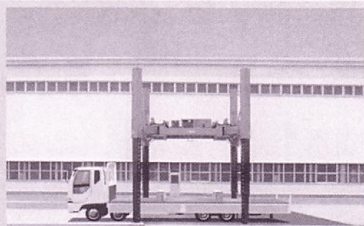
④ジャッキを全伸長し、リフター搬送用トラックを外す。(ラジコンにて地上より操作)
